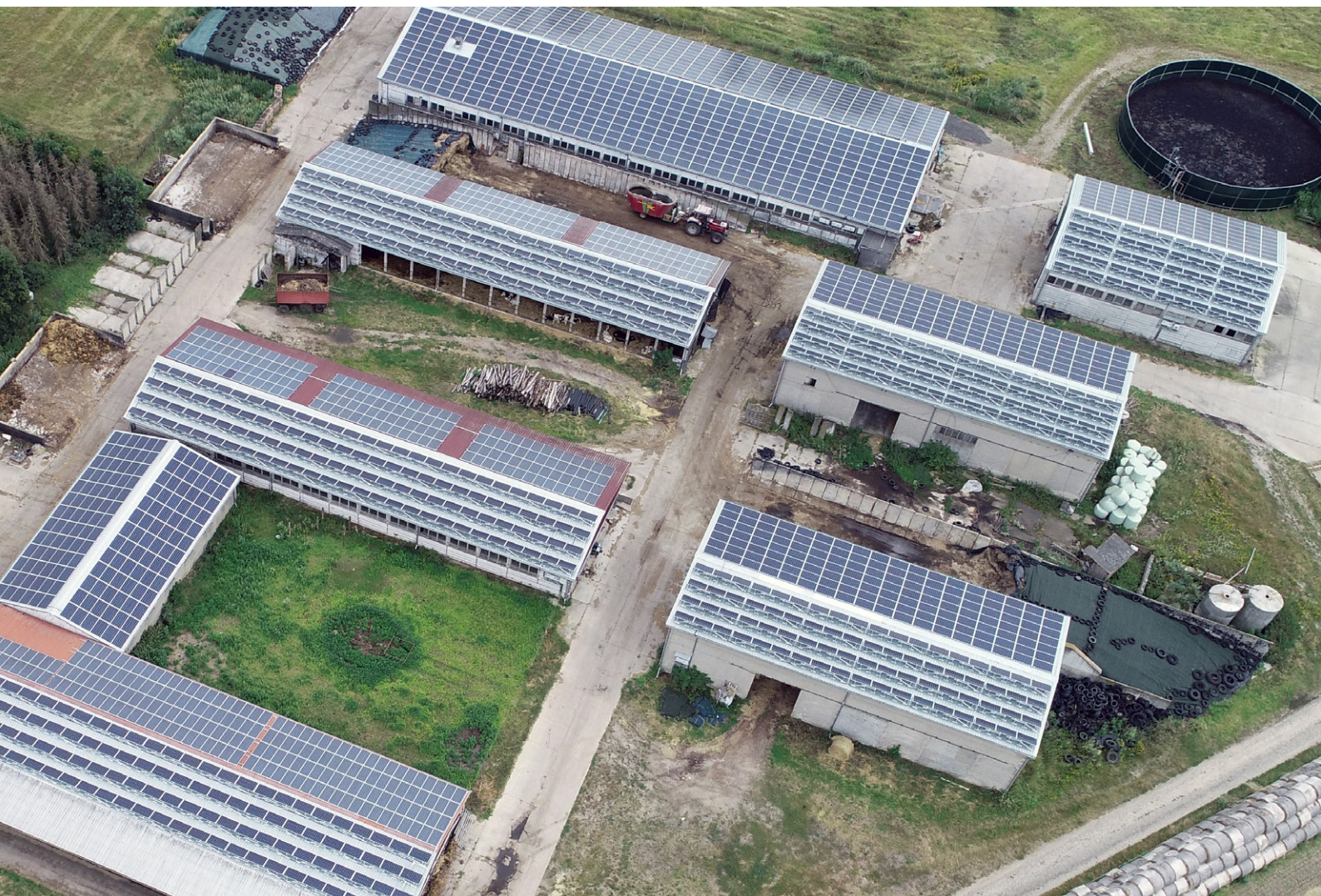
Güsselfeld-Kalbe – Anlageobjekt ZUKUNFTSENERGIE DEUTSCHLAND 4
