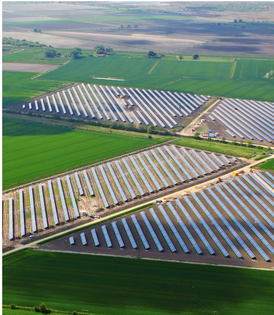
Meldorf – Anlageobjekt SOLARENERGIE NORD
